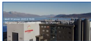
Atelier / Réseau de Chaleur (SWEN)
